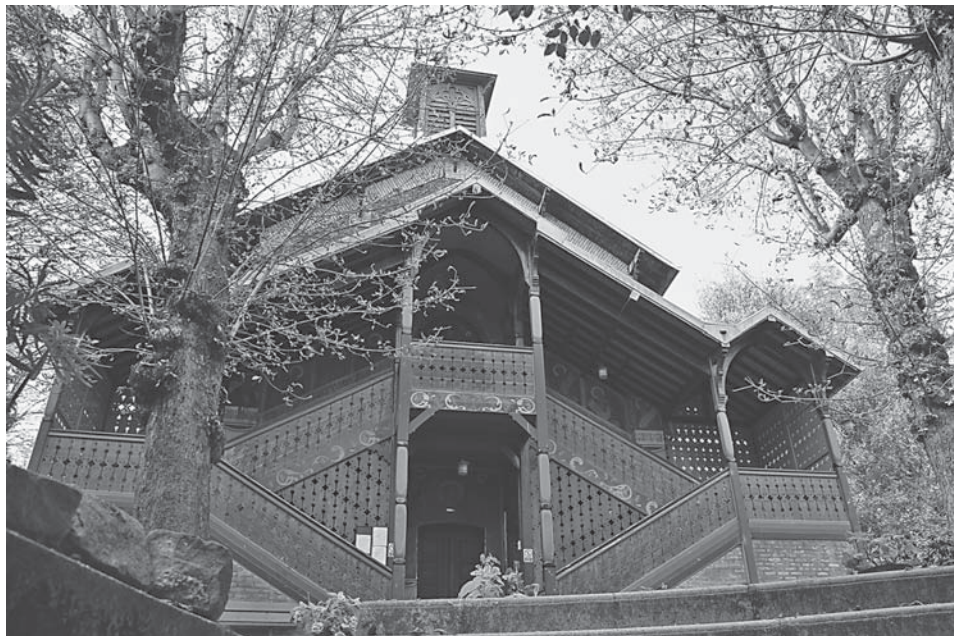
Общий вид фасада храма преп. Сергия с двумя лестницами на второй этаж
