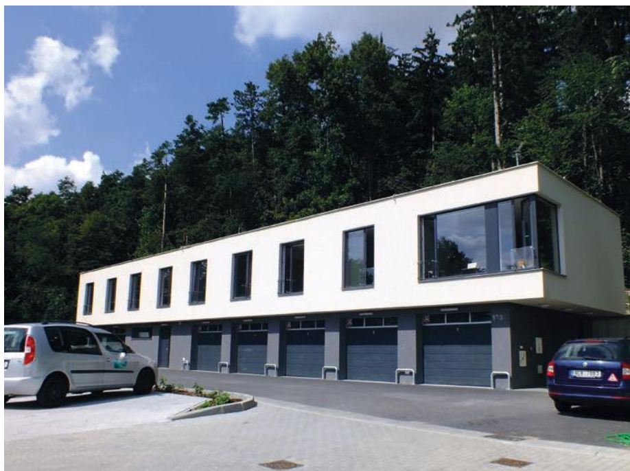
Budova „domečku“ v Zátěši ve Vodňanech slouží jako ubytování pro doktorandy, sídlí zde také část pracovišť fakulty.
