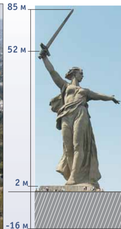
Общая высота скульптуры — 85 метров. Высота — 52 метра. Длина руки — 20 м. Длина меча — 33 м. Вес скульптуры — 8000 т, вес меча — 14 т.
