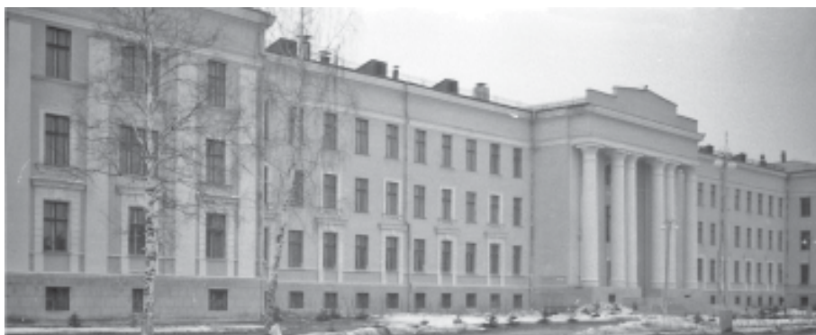
Здание Обнинского филиала МИФИ, только что принятое в эксплуатацию
