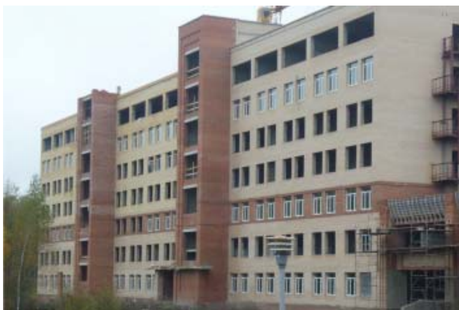
Строящийся корпус естественно-научного факультета
