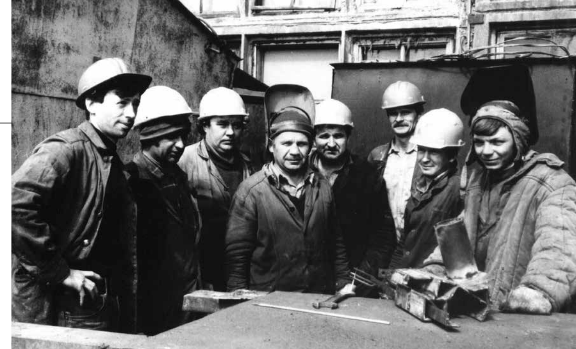
Бригада ремонтников второго целлюлозного завода
