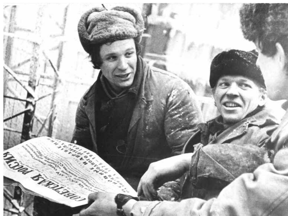
Александр Сазонов и Сергей Разуваев — передовики-монтажники бригады СГЭМ В. Большакова
