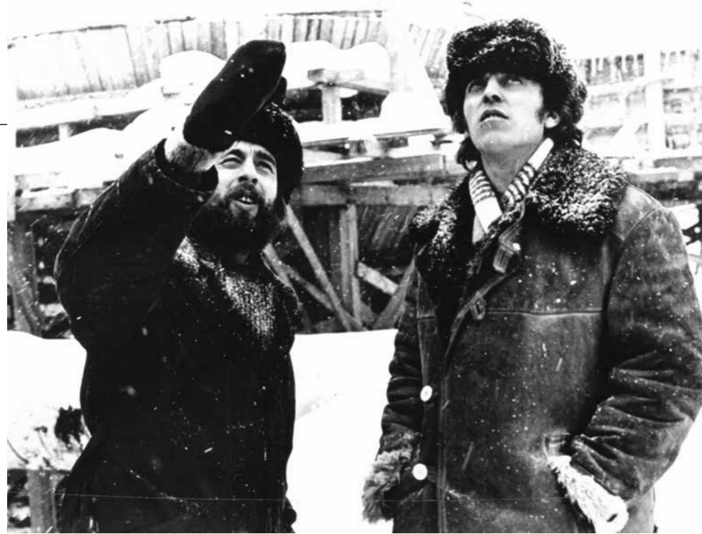
На строительстве очистных сооружений прораб В.Ф. Курьянов (справа) и строитель немецкого стройотряда
