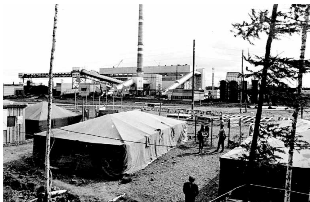
Ударный отряд студентов на строительстве ТЭЦ-2
