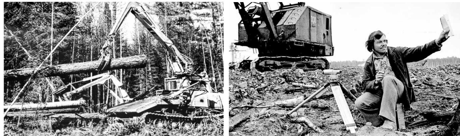
5 ЯНВАРЯ НАЧАЛСЯ СВОД ЛЕСА ПОД ПЛОЩАДКУ ЛЕСОПРОМЫШЛЕННОГО КОМПЛЕКСА
