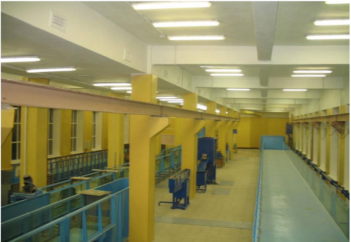
Рис. 10. Гидротехническая лаборатория после ремонта 2006 г.
