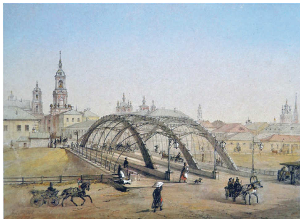
Вид Чугунного моста. И.И. Шарлемань. 1853 год. Первый мост через Водоотводный канал (или, как его называли раньше, Канаву) в Замоскворечье
