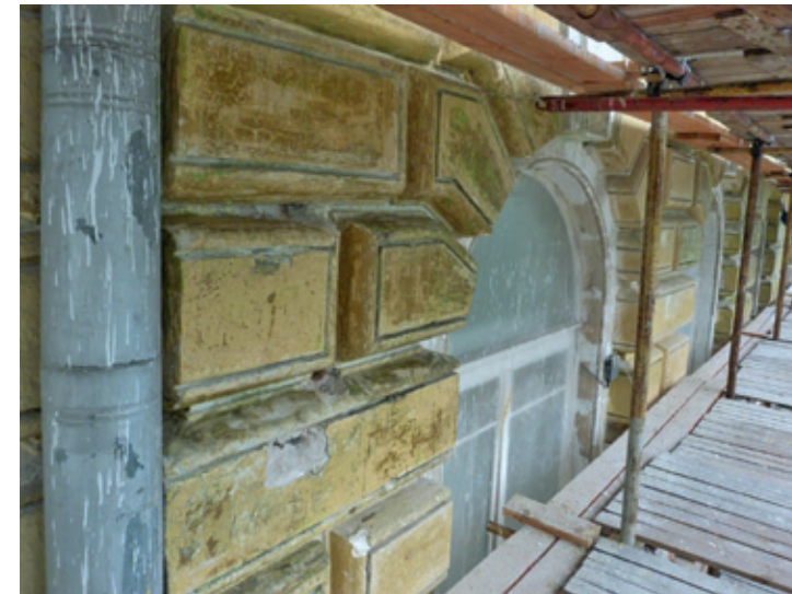
Фасады Московской консерватории до и после реставрации
