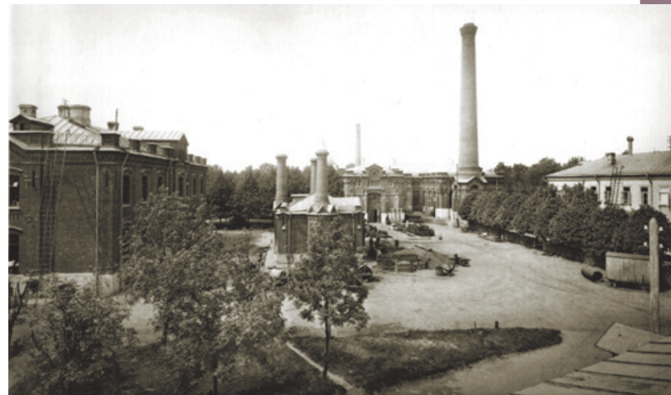
Алексеевская насосная станция служила в XIX веке для перекачки воды из Мытищ в Крестовские водонапорные башни. Фото 1913–1914 годов
