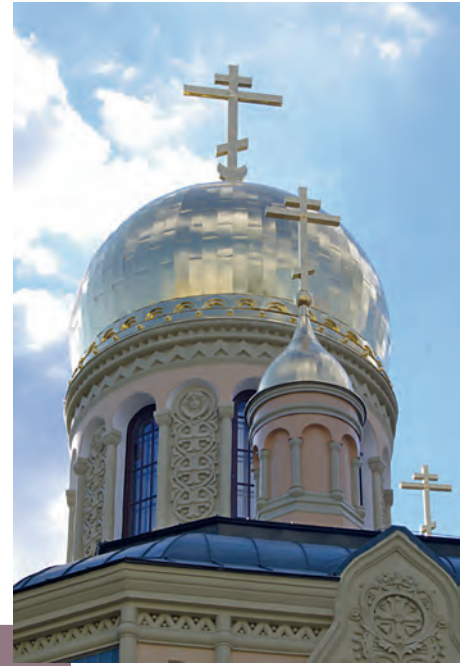
Четвертый корпус РЭУ им. Г.В. Плеханова – церковь иконы Божией Матери «Взыскание погибших»
