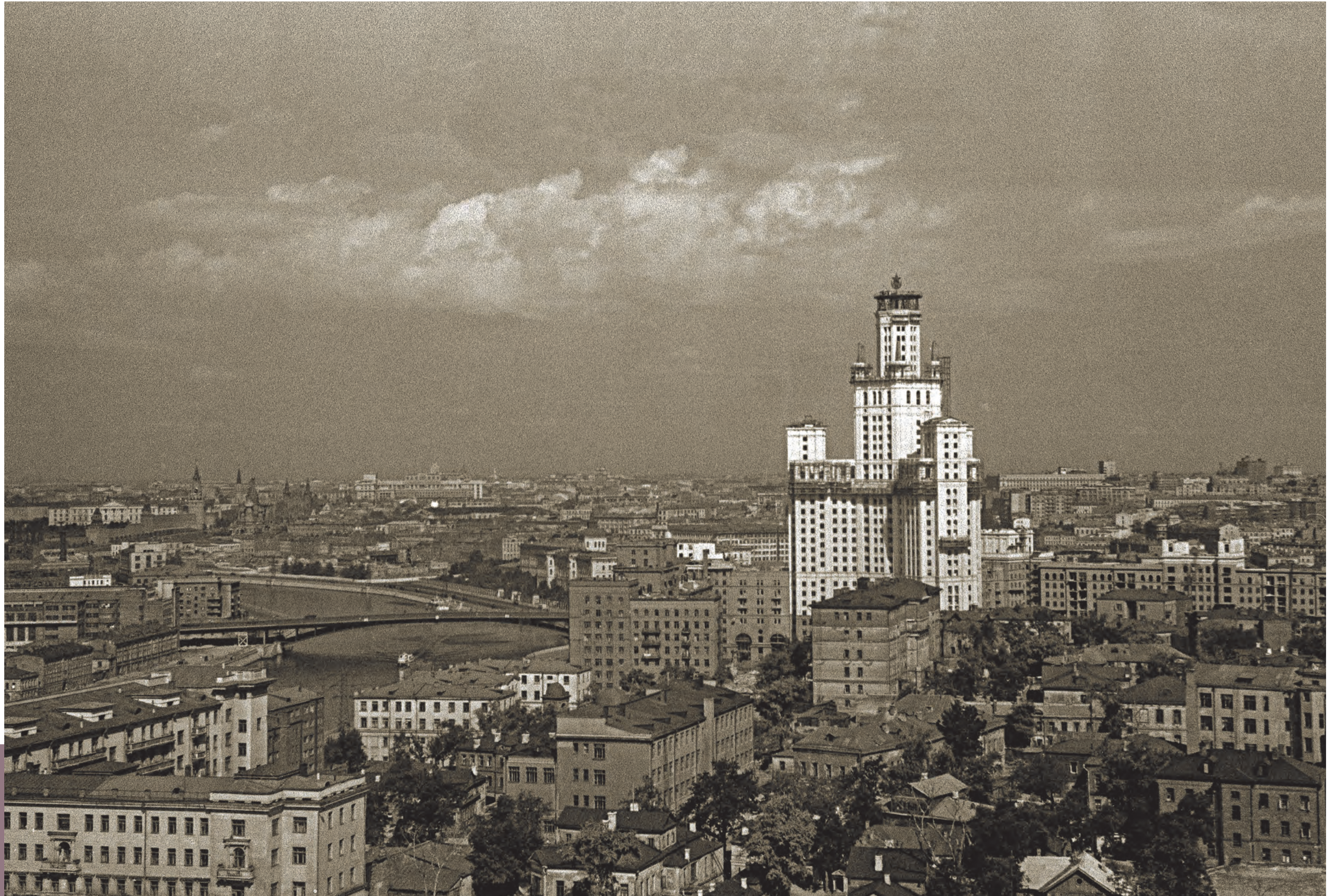
Фотография предоставлена Главным архивным управлением города Москвы. Вид со Швивой горки на строящуюся высотку на Котельнической набережной. 1950-е годы. Высотка еще не «вобрала» в свой состав дом на набережной и пока лишена шпиля. Главный архитектор Москвы этого периода, Чечулин, пока еще не получил квартиру в высотке. Квартиру с видом на Кремль, который отсюда очень хорош
