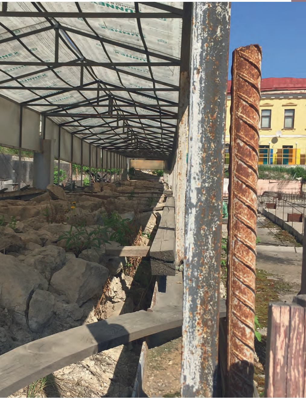
Вид на фундамент стены Белого города со стороны строительной площадки. Уже более 10 лет белый камень закрывает от московской непогоды специально сооруженный навес
