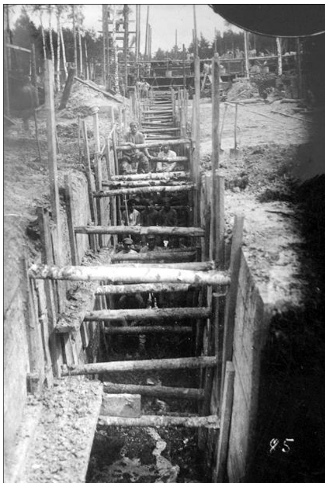
1919. Траншея под фундамент Временной электростанции
