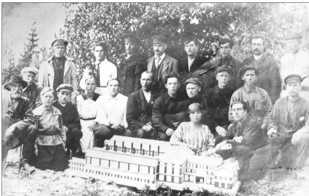
У макета будущей ГРЭС.
