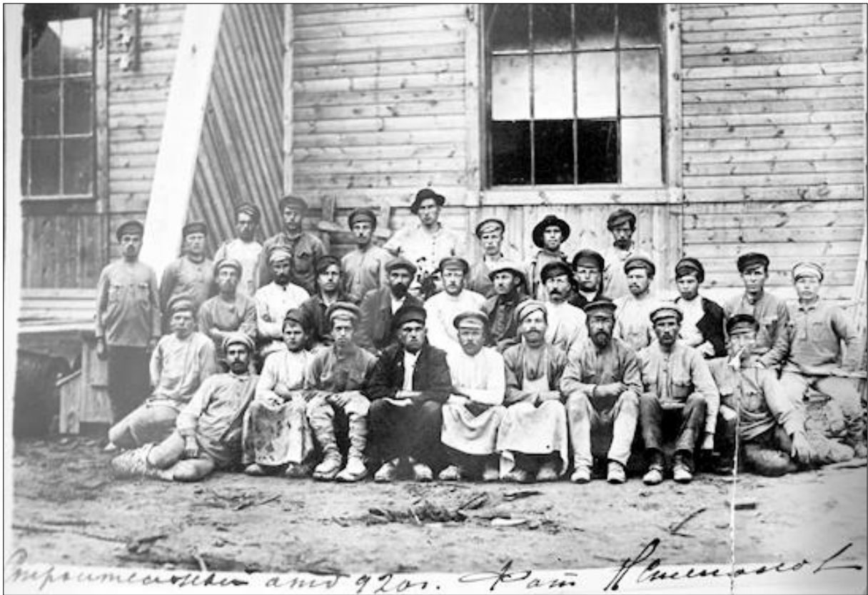
Строительный отдел 1920 г. Фото Н. Степанов.
