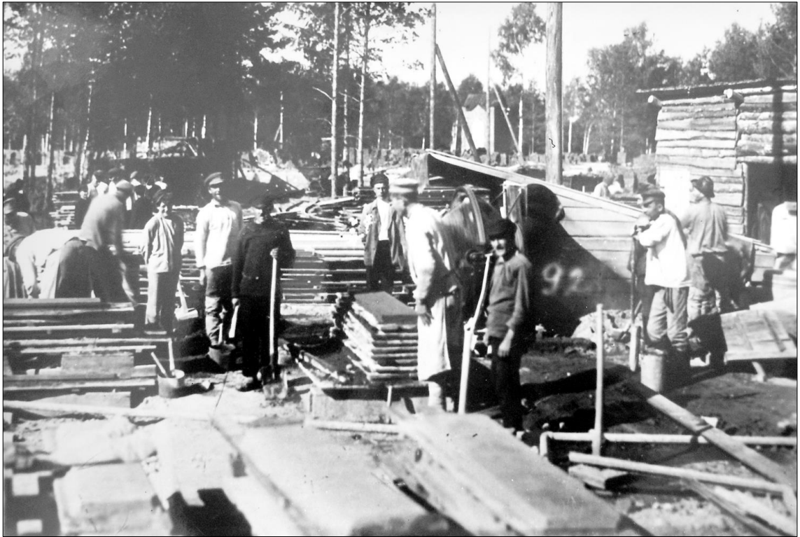
Строительство Временной электростанции.
