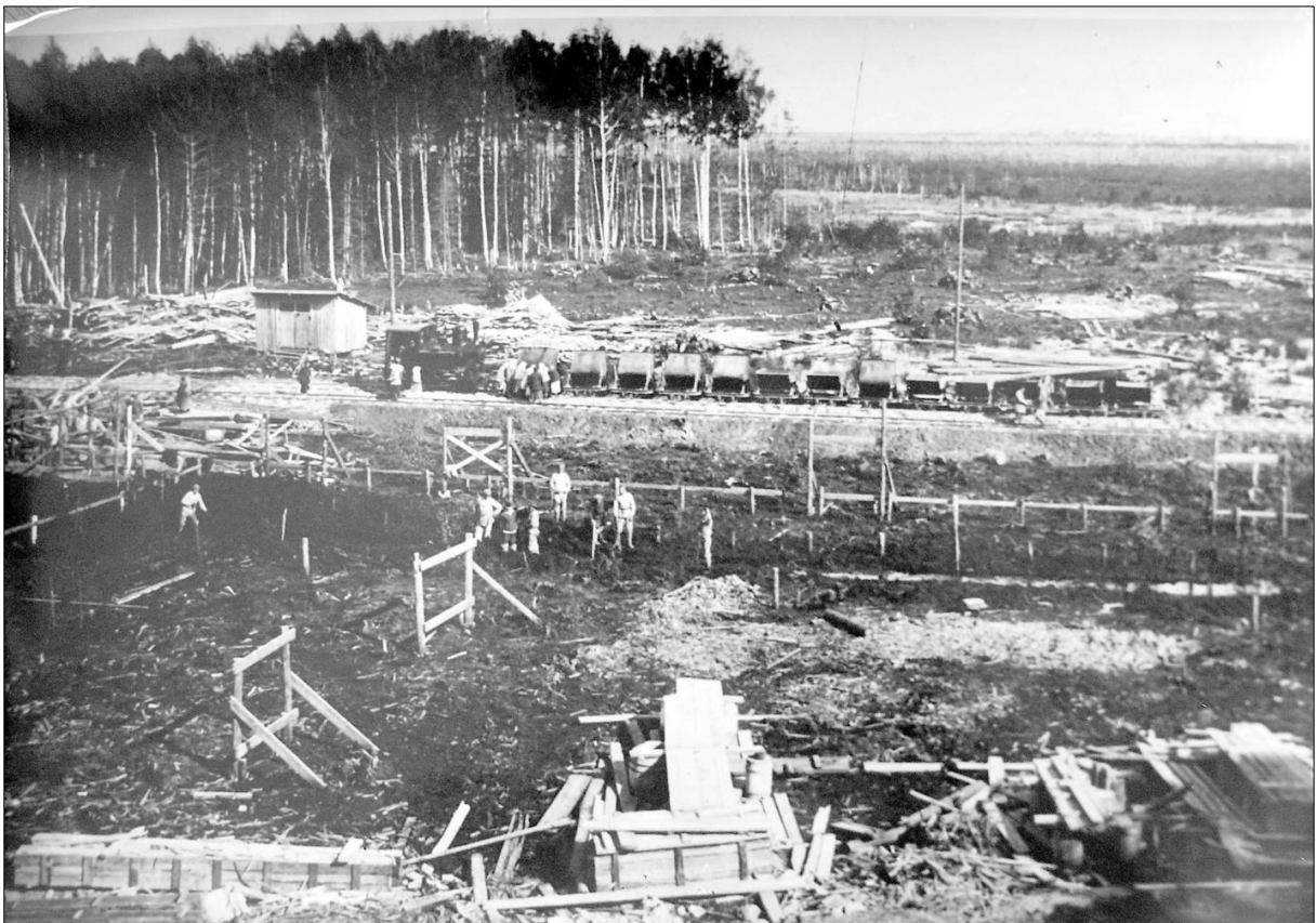
Строительство Временной электростанции.
