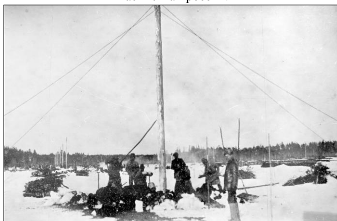
Установка столбов для линии передачи.
