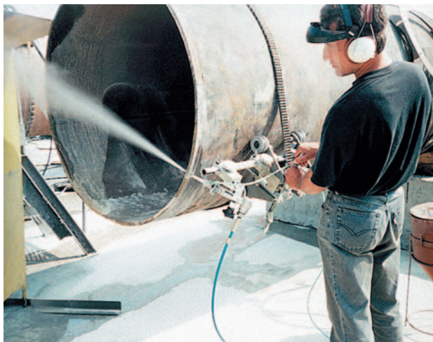
Резка стального трубопровода струей воды.
