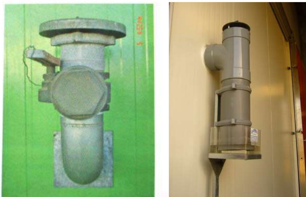
Figura 6. a) Válvula de sobrepresión; b) Válvula de depresión (Fuente: Bahamondez, 2015).
