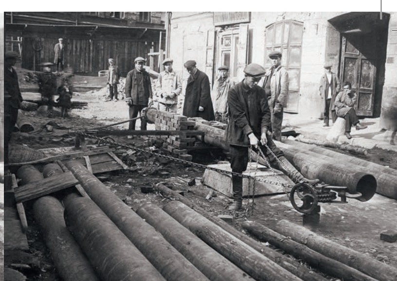
Гнутье труб для прокладки на улицах Москвы
