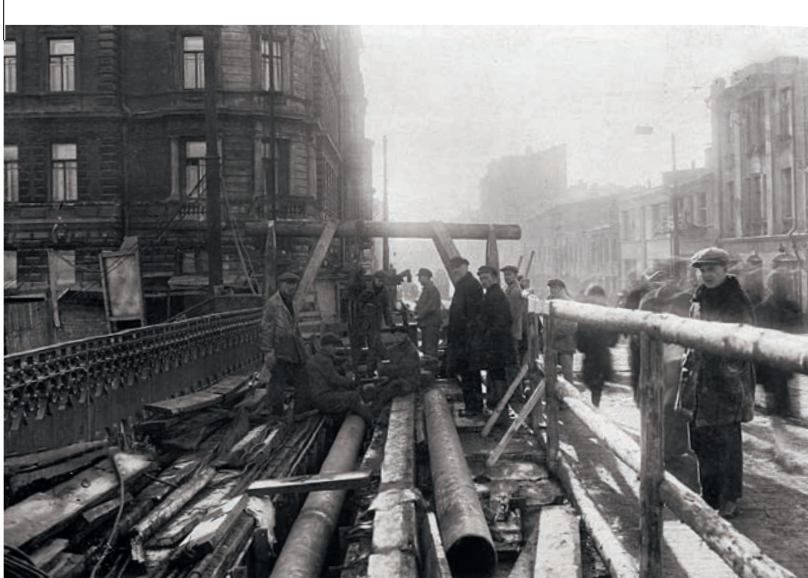
Монтаж участка тепломагистрали на Малом Москворецком мосту, 1930-е гг.
