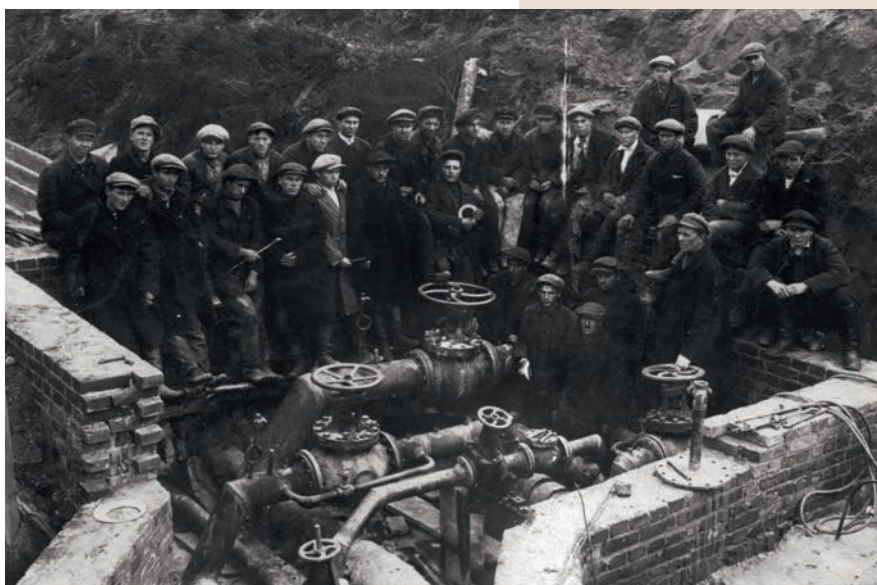
Монтаж паропровода. Москва, 1931 г.
