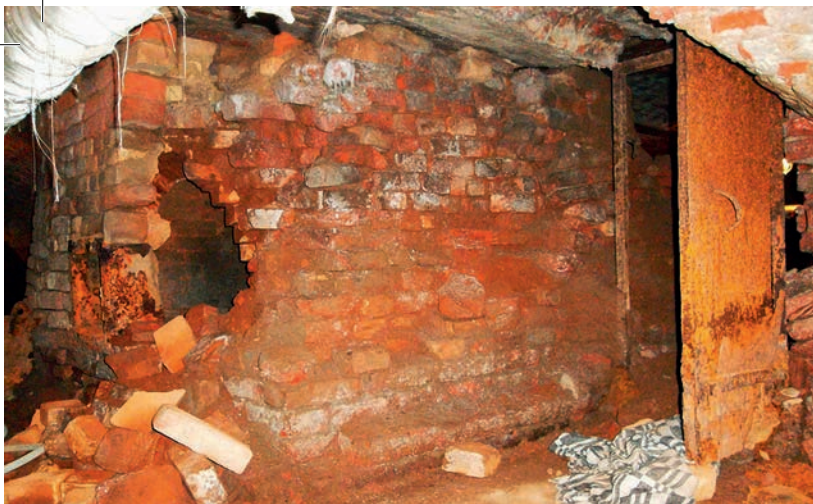
Остатки аммосовской печи в Малом Эрмитаже. Топка и вход в воздушную камеру
