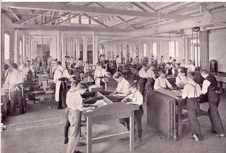
Батарея отопления в цеху
