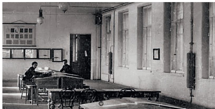
Вертикальные радиаторы отопления
