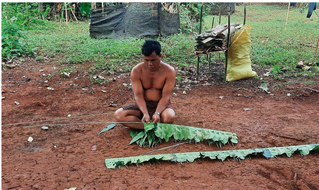
Ил. 11. Подготовка к строительству дома, народ тампуан. Камбоджа, пров. Ратанакири, 2022 г.
