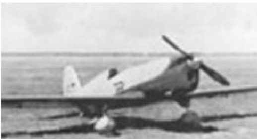
IS-1 – спортивный одноместный цельнодеревянный низкоплан. Материал – фанера, оклеенная тканью. Тормозные щитки типа Шренка на крыльях. Фюзеляж – типа монокок. Шасси – раздельное, с масляно-воздушной амортизацией.
