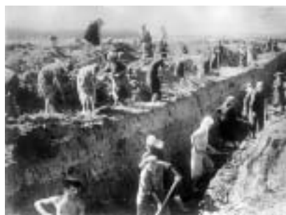
Жительницы пригородных деревень на строительстве оборонительных сооружений
