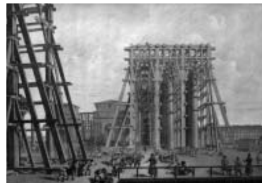
Строительство Исаакиевского собора
