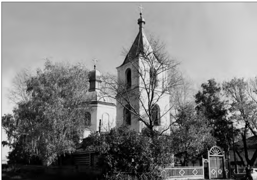
Покровская церковь в селе Темяшево. Фото 1980-х годов.
