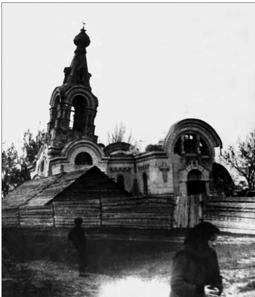
Никольская церковь города Тамбова. Разрушение.
