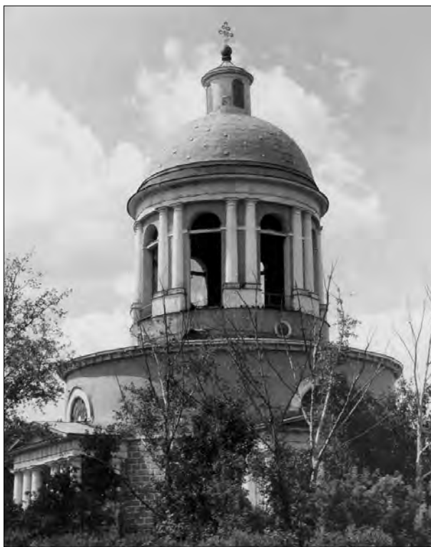
Село Бондари. Троицкая церковь. (Построена в 1839 году.)
