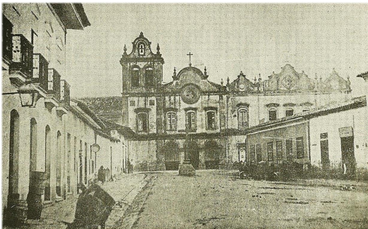
Figura 34: Cruzeiro de pedra de cantaria existente no Largo de São Francisco até 1870.
