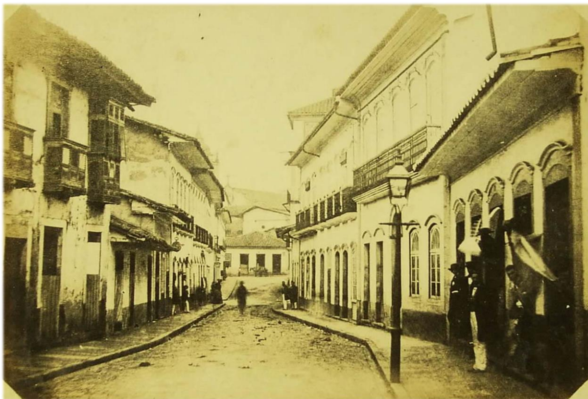
Figura 35: MILITÃO, Augusto de Azevedo. Rua do Rosário , 1862/1863, onde podemos observar a iluminação das ruas.
