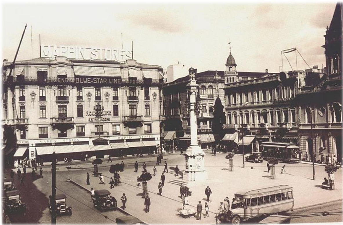
Figura 42: GERODETTI, João Emílio; CORNEJO, Carlos. Praça do Patriarca , São Paulo, 1920. No canto à direita podemos visualizar a Igreja de Santo Antônio, quase desaparecida na nova paisagem urbana.
