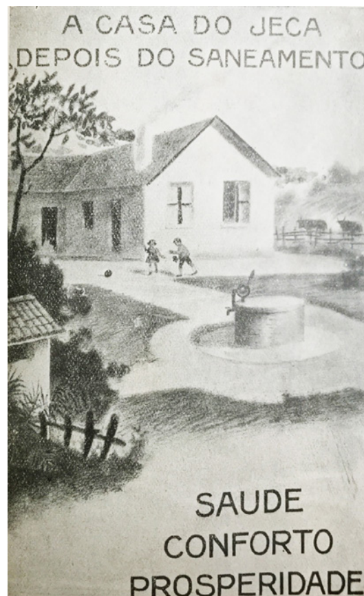
Figura 2.4 Moradia higiênica -depois do saneamento.
