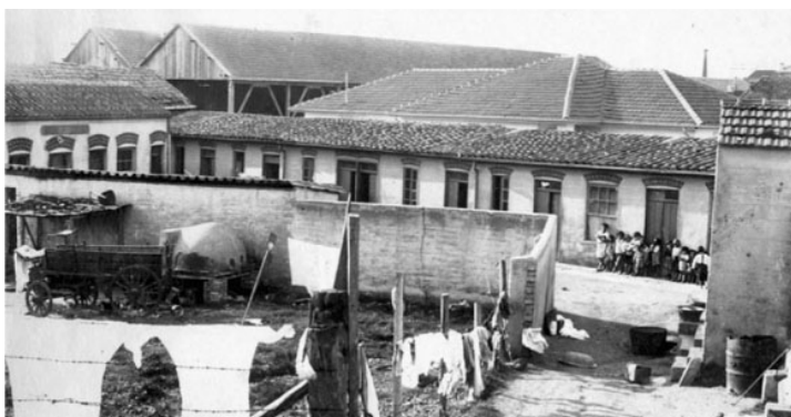
Figura 2.7 Vista interna de um cortiço na cidade de São Paulo.
