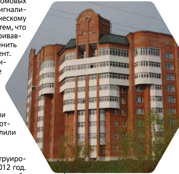
Дом, построенный по заказу завода, с монолитным плавающим фундаментом
