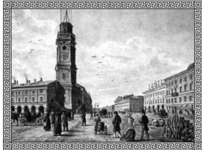
Петербург нач. XIX в. Невский проспект. Полицейский мост
