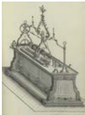
Рис. 3. А.К. Нартов. Токарно-винторезный станок. Первая половина XVIII века
