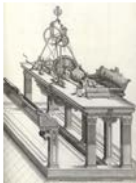
Рис. 4. А.К. Нартов. Токарно-копировальный станок. Первая половина XVIII века
