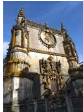
Рис. 2. Западный фасад церкви
