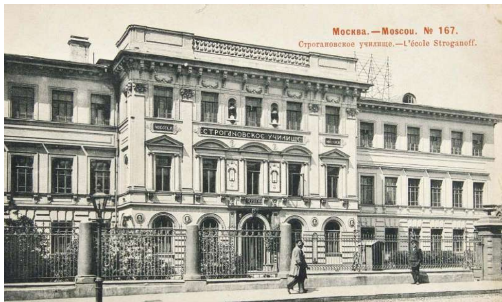
Ил. 1. Фасад Строгановского училища. Фото 1900х гг. Открытка издательства Шерер, Набгольц и Ко. Серия Москва, № 167 Строгановское училище. Оригинал хранится в Архиве музея РГХПУ им. С.Г. Строганова
