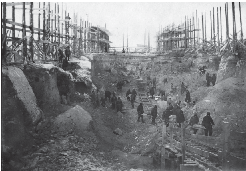
Работа на котловане
