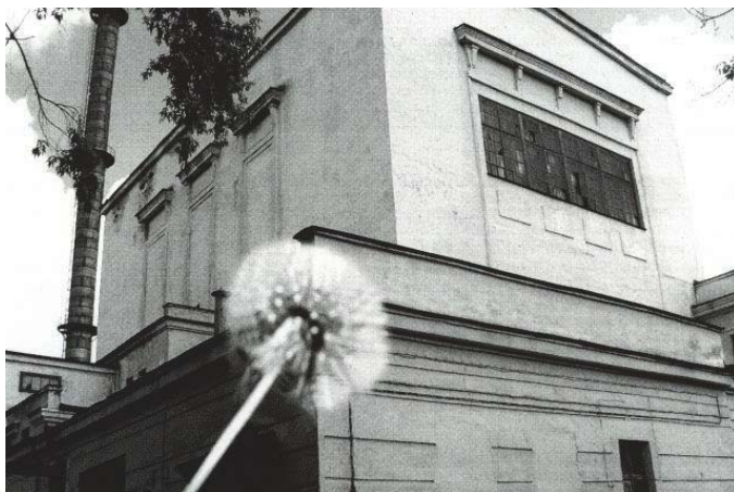
Здание, в котором располагался реактор
