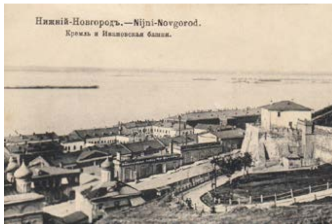
Вид на Волгу и завод торгового дома «Братья Фроловы» у Ивановских ворот. Открытка фотоателье М. Дмитриева
