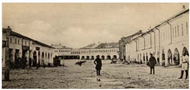
Фото 1. Торговые ряды. Восточный корпус в г. Угличе
