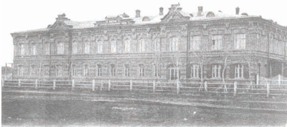
Здание училища, построенное в 1903 году.
