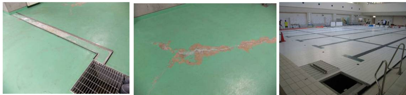
【地下漏水修繕箇所】
