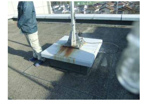
【屋上避雷針架台補修】
