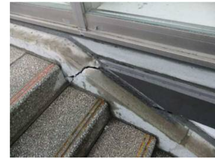
【屋外階段基礎取り合い シール打ち替え】
