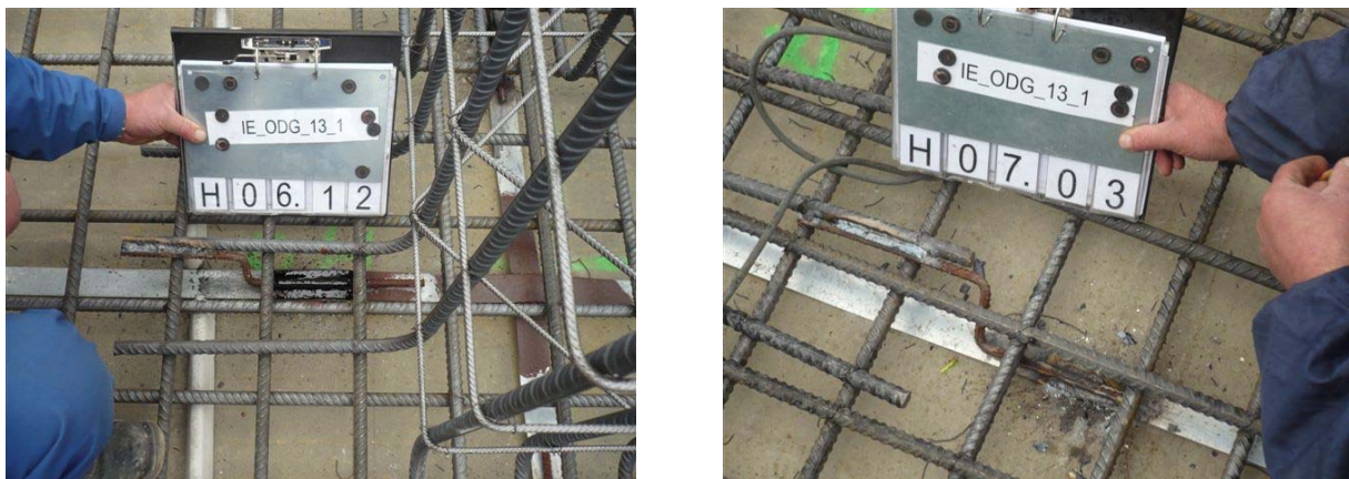
Rys. 8. Dokumentacja fotograficzna powykonawcza połączeń prętów zbrojeniowych z płaskownikiem uziomowym
