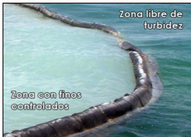
Figura 2. 47. Cortina antidispersión de sedimentos.
