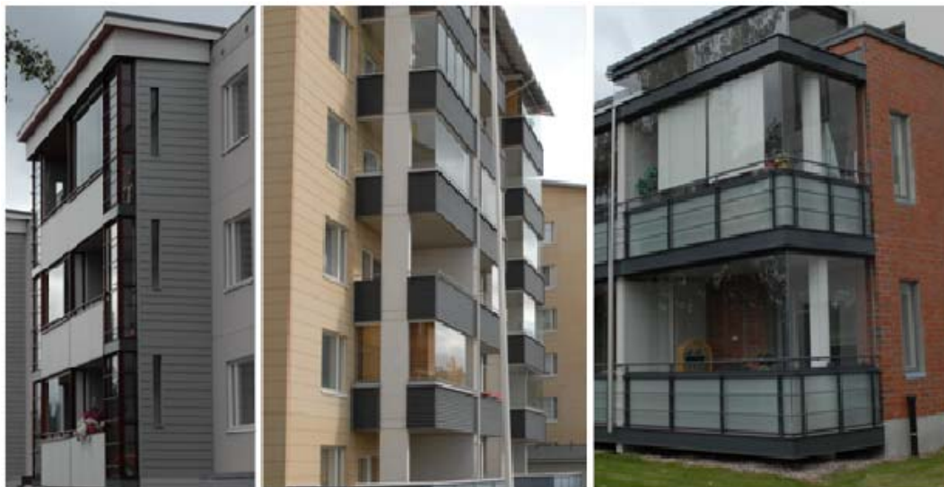
Kuva 6.29. Kolme vähiten energiaa säästävää lasitettua parvekettä. Kohteet vasemmalta lukien Peltovainionkatu 4 (vv. 1974), Härmälänsaarenkatu 13 (vv. 2002) ja Rientolankatu 5 (vv. 2006).
