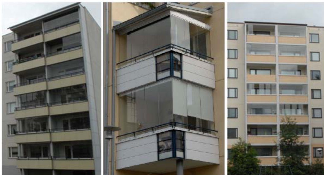
Kuva 6.28. Kolme eniten energiaa säästävää lasitettua parveketta. Kohteet vasemmalta lukien Opiskelijankatu 28 (vv. 1975), Siirtolapuutarhankatu 22 (vv. 2000) ja Teekkarinkatu 9 (vv. 1976).
