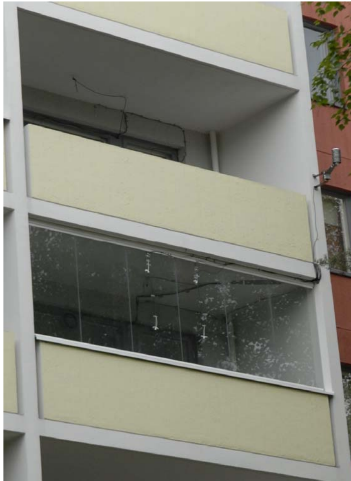
Kuva 4.3. Kenttämittaus tietokonelaitteistolla suoritettiin kahdella parvekkeella päällekkäisellä parvekkeella, joista toinen oli lasitettu ja toinen lasittamaton.
