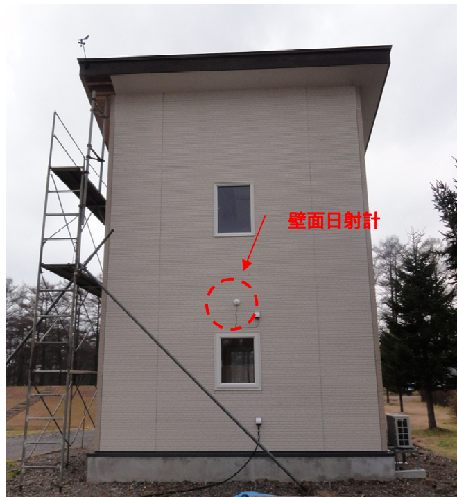
図 5-4 壁面日射計設置状況（東面）
