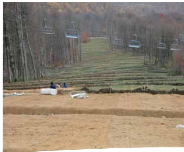
Bruk av kokosmatter er en effektiv måte å binde jordsmonnet og revegetere terrenget der det er bratt.
