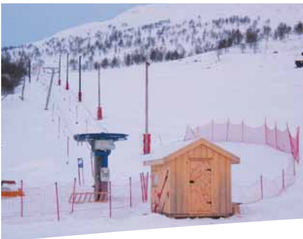
Slepeheis fås med medbringere som T-kroker eller "skåler".
