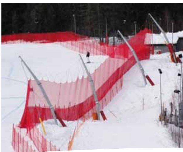
A nett brukes ved sikring av utsatte partier av fartsløyper og henger i wire mellom master som er faste innretninger.
