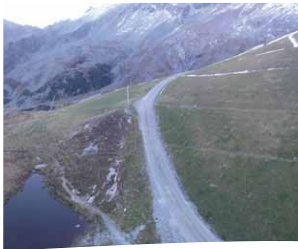
Anleggsvei er nødvendig infrastruktur i fjellet og bør føye seg skånsomt inn i terrenget.
