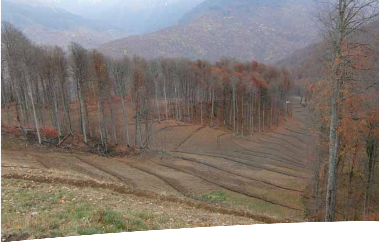
God drenering er vesentlig for å hindre erosjon.
