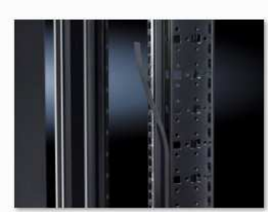
Abbildung 9: Magnetisch beschichtete Dichtleisten verschließen ungenutzte Lochreihen
