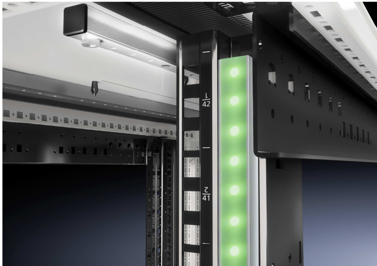
Abbildung 12: Dynamic Rack Control unterstützt das Asset-Management über RFID
